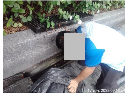
รูปที่ 2-30 การทำความสะอาดชุดลอกบ่อพักและท่อระบายน้ำ
