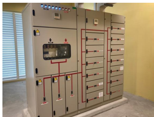
รูปที่ 2-26 แยกมิเตอร์ไฟฟ้าสำหรับระบบบำบัดน้ำเสียออกจากมิเตอร์ไฟฟ้าสำหรับใช้ในอาคาร
