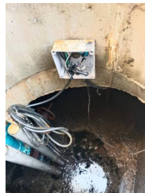
รูปที่ 2-22 การตรวจสอบดูแลและซ่อมบำรุงเครื่องสูบน้ำเสีย และเครื่องเติมอากาศของระบบบำบัดน้ำเสีย
